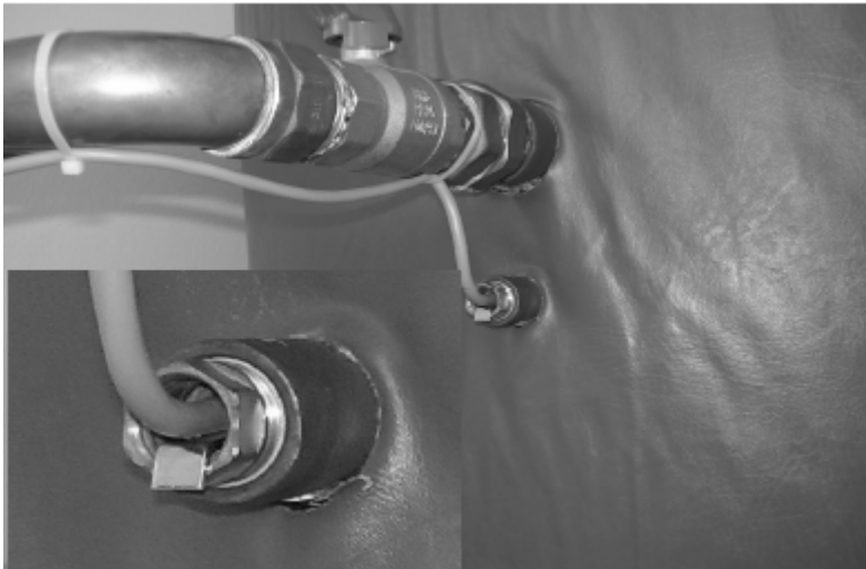
Pośredni czujnik PF lub CWU w podstawie bufora. Czujnik PF musi być zamontowany 10 cm poniżej wejścia przewodu wejściowego. Nie zaleca się mocowania go do niego (może wystąpić wadliwa praca sterownika). !!
