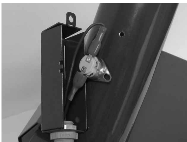
Rys. 10 - Termostat bezpieczeństwa przy zasypie komory spalania, 95 °C
