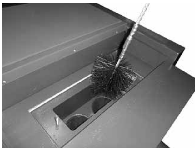
Dokładne wyczyszczenie wymiennika rurowego (den sitowych) szczotką
