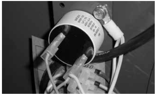
Lokalizacja kondensatora rozruchowego (1µF) wentylatora wyciągowego (oprócz D10PX)
